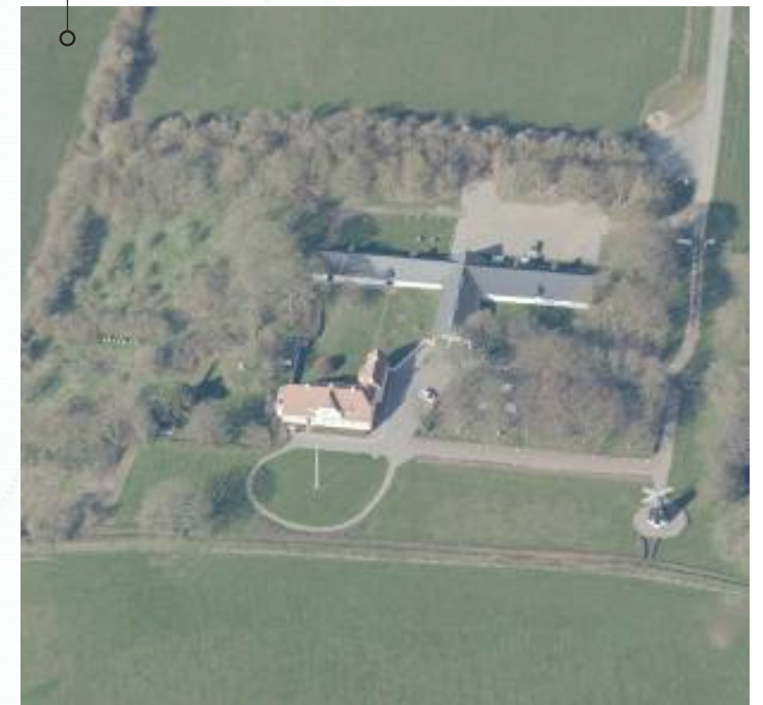
1. Januar 2006 overtog Skive kommune bygningerne og lod Aakjærselskabet drive anlægget som museum. Her ses et luftfoto af området i dag. Den nye stald er blevet kalket hvid som de øvrige længer, og en parkeringsplads ses øverst i billedet.
